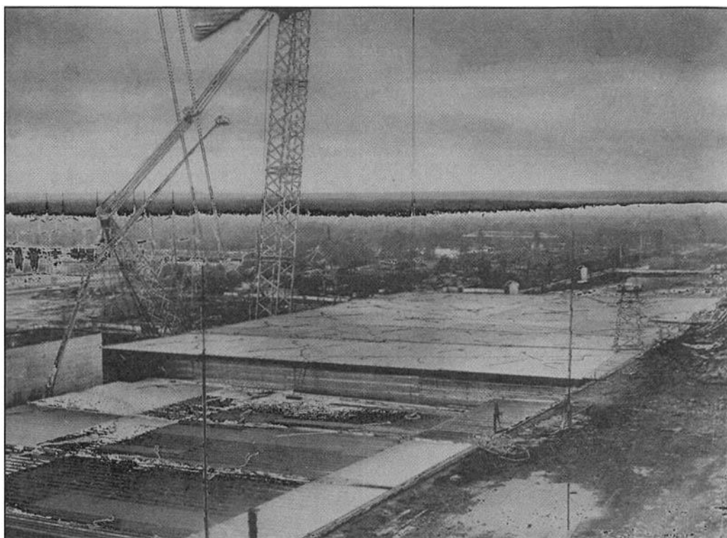
На фото: перекрытие машинного зала.
