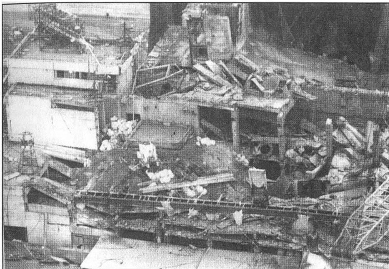
«Песочница». Видно заполнение щелей мешками и бетоном. Постоянно на месте создания опоры дежурит «Батискаф».
