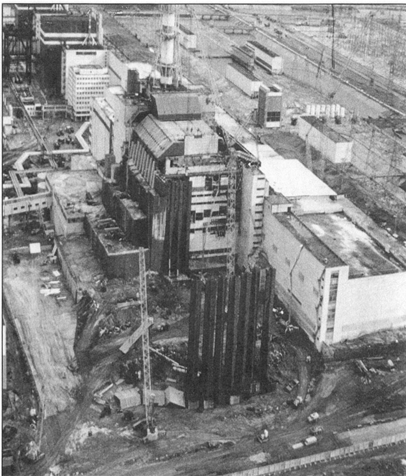
Первые стенки на монтаже
