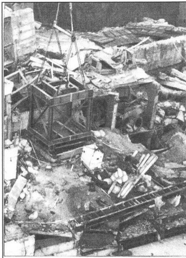
Монтаж силового короба опоры под балку. Видна опора для клюшек.
