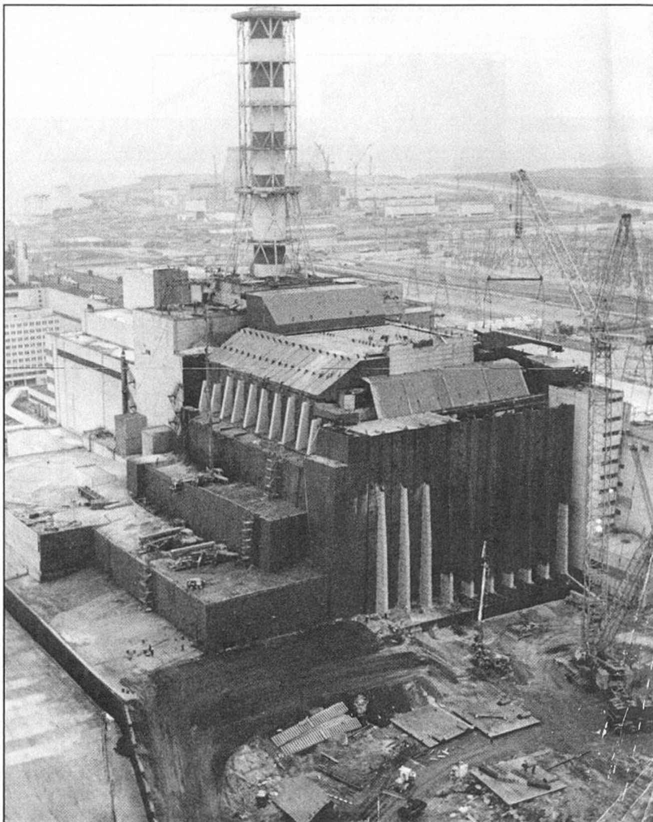
На фото: 12 ноября 1986 года. Закончено бетонирование ступеней «Саркофага», идёт подготовка к снятию бетононасосов с отметок. Монтируется последняя «клюшка» со стороны машзала. Идет окраска металлоконструкций. Подходят к концу планировочные работы.
