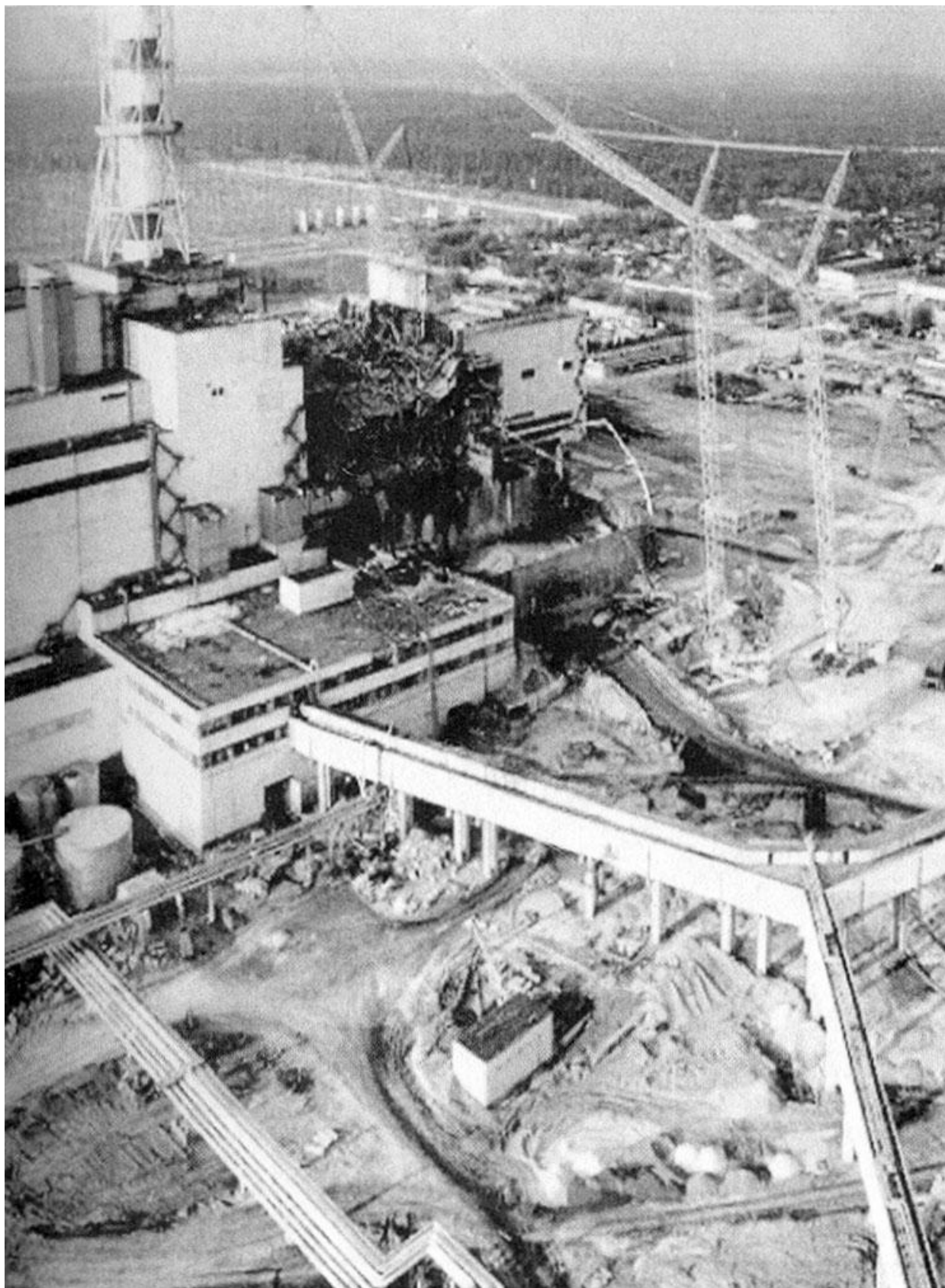
Общий вид на момент установки 2-ой стены.
