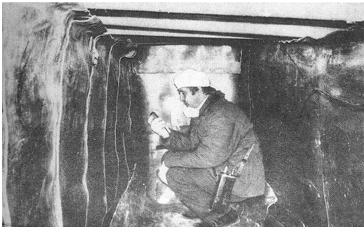
Наблюдательный пункт. Стены облицованы свинцом. Идет подготовка к монтажу.
