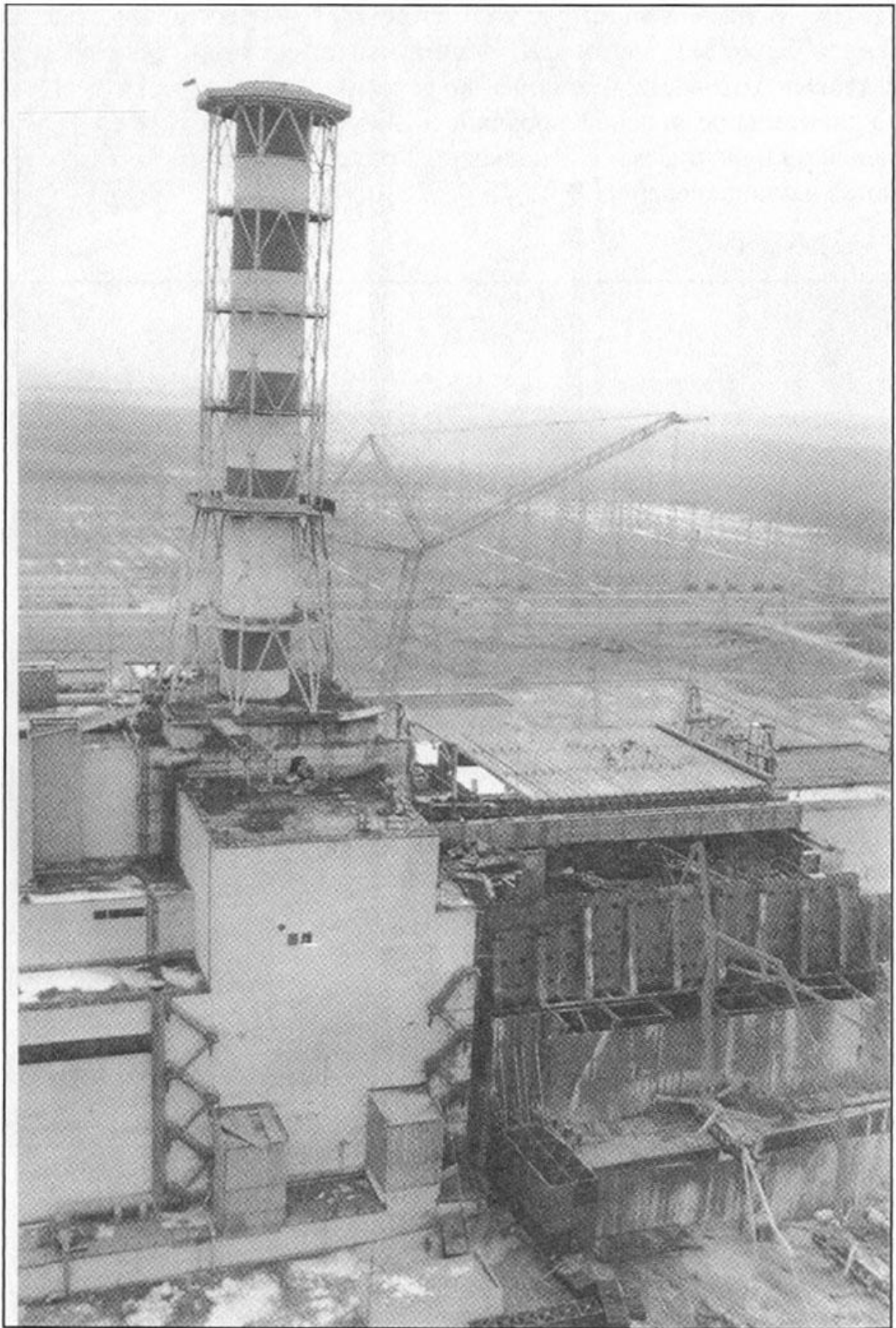
Общий вид со смонтированными трубами перекрытия реактора. Виден флаг на вытяжной трубе реактора, установленный военными. Эта бравда обошлась жизнью этих людей.
