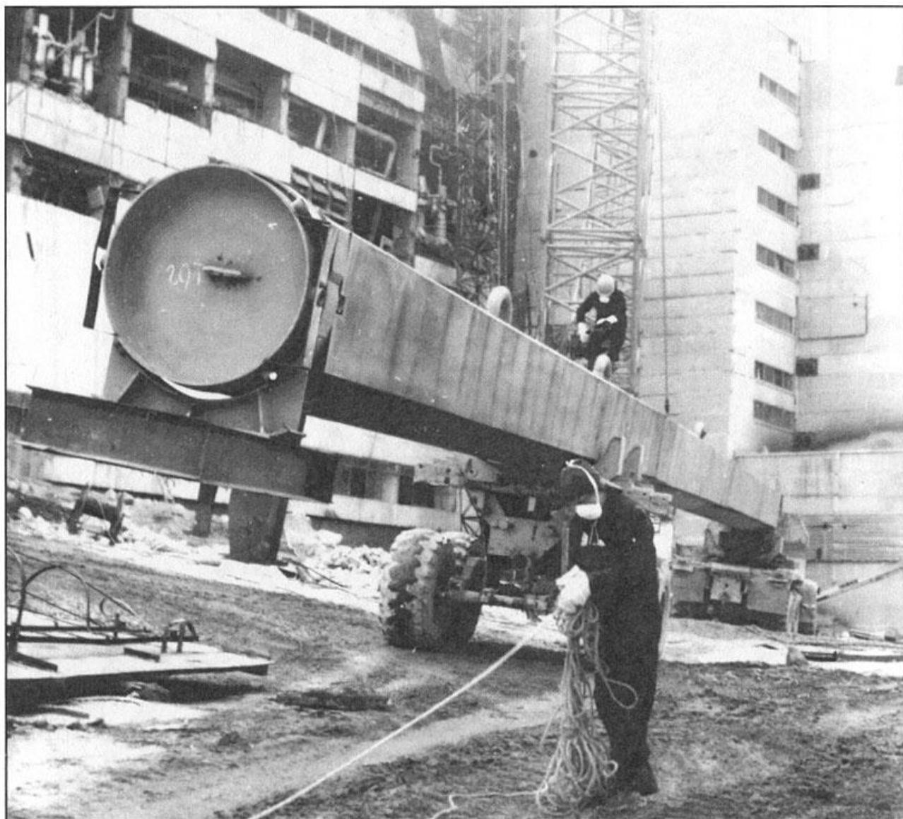
Завоз на площадку труб-балок перекрытия. В торце балки перекрытия видна скоба, а в руках монтажника фал-веревка, при помощи которой будет корректироваться конструкция на подъеме. Балка готовится на подъем.
