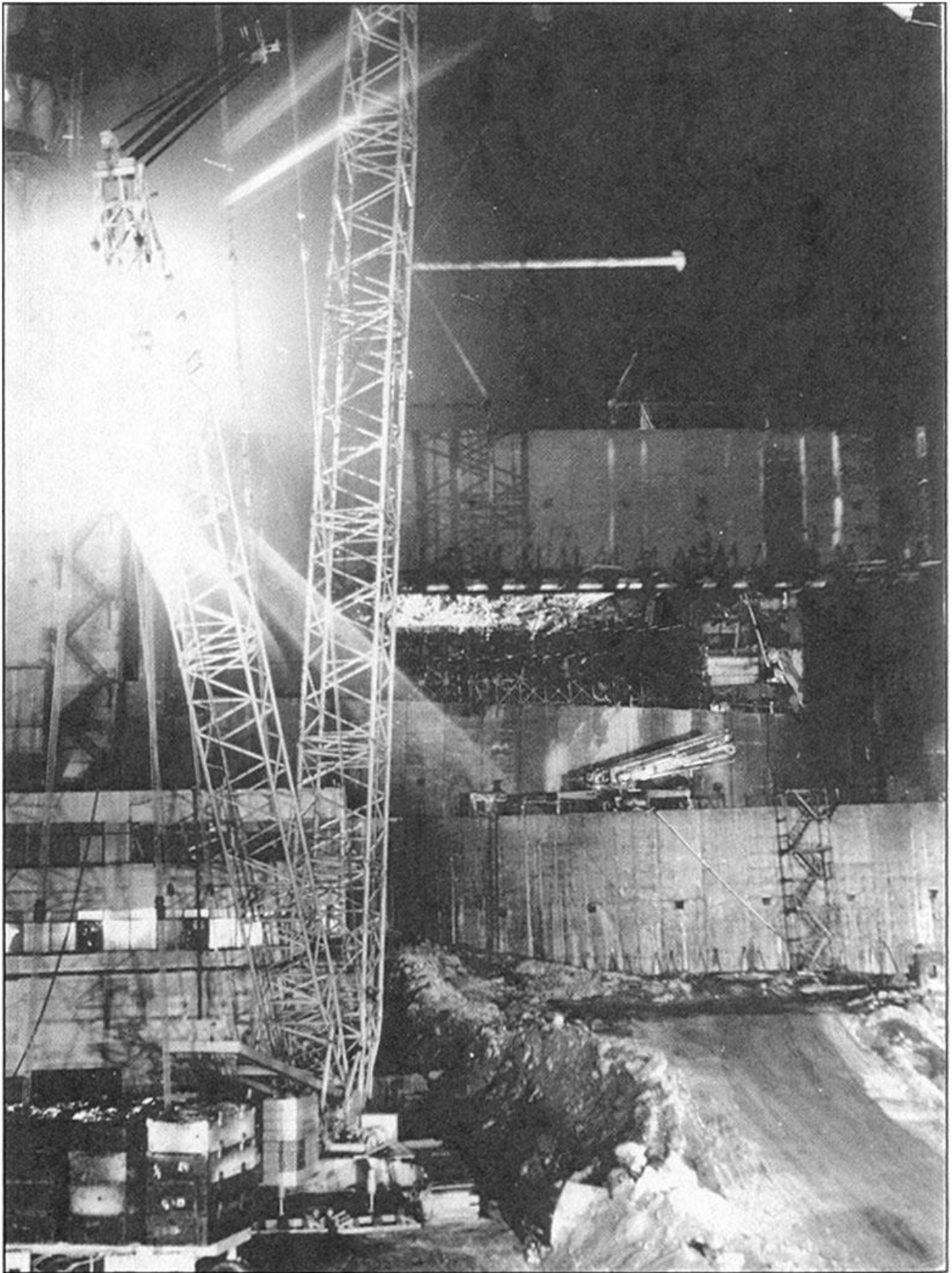
Стенка вошла в завал. Заключительный этап монтажа третьей стенки.
