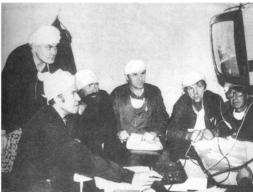
Контроль и коррекция при монтаже каркасной стенки.
