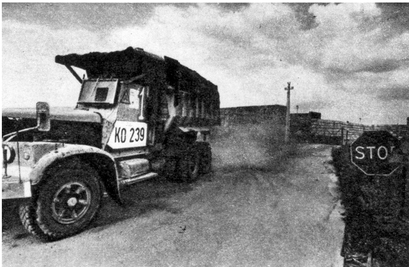
Вывоз радиоактивного грунта с территории АЭС
