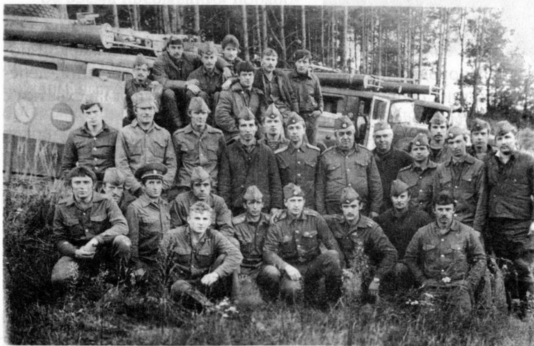
Отряд могилевских пожарных в 30-км зоне.
