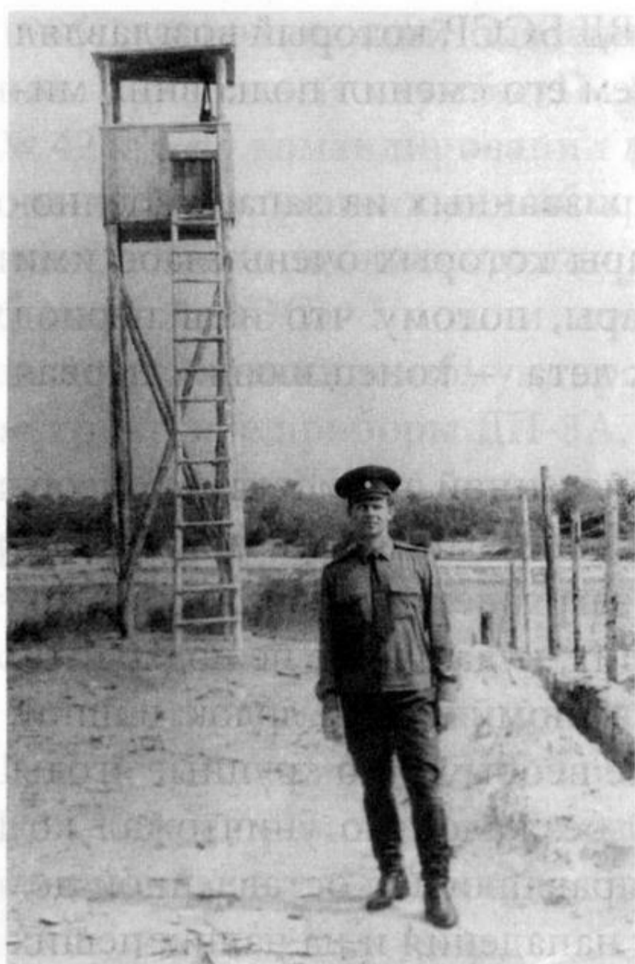
Наблюдательная вышка у д. Довляды Наровлянского района, до АЭС — 5 км
