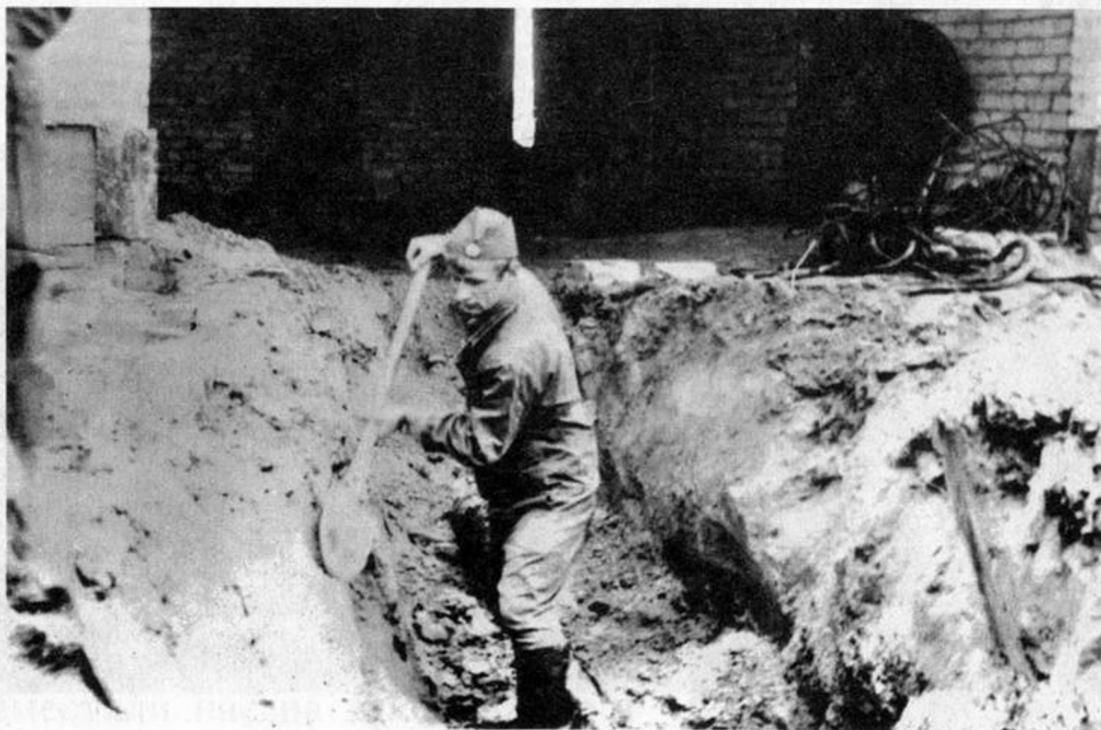
Рытье котлована под пожарное депо в г. Брагине.
